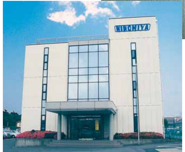
本社 Head Office 建物 1,114㎡
