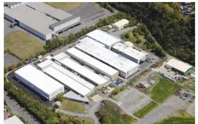
長南工場全景 Chonan Plant 敷地 64,250㎡ 建物 14,429㎡
